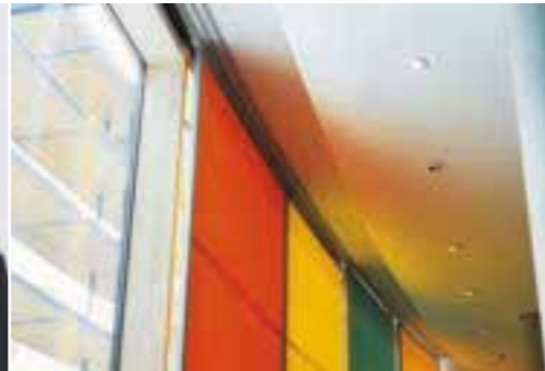
Alu-Funktionsprofil mit Schiebepaneel LVA, Augsburg
