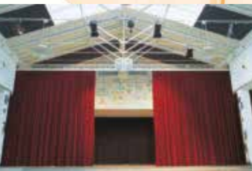
Alu-Vorhangschiene mit Bühnenvorhang JMS-Gymnasium, Dillingen (oben: Satteldach-Vollverdunkelung)
