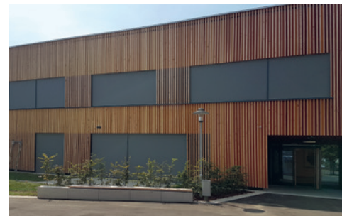
Für das Projekt Langenpreising nutzte Brichta Sondersysteme hinter Holzfas-saden
