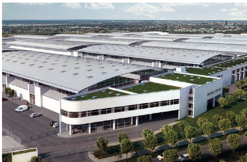
Auch das Gebäude der Messe München stattete das Unternehmen aus
